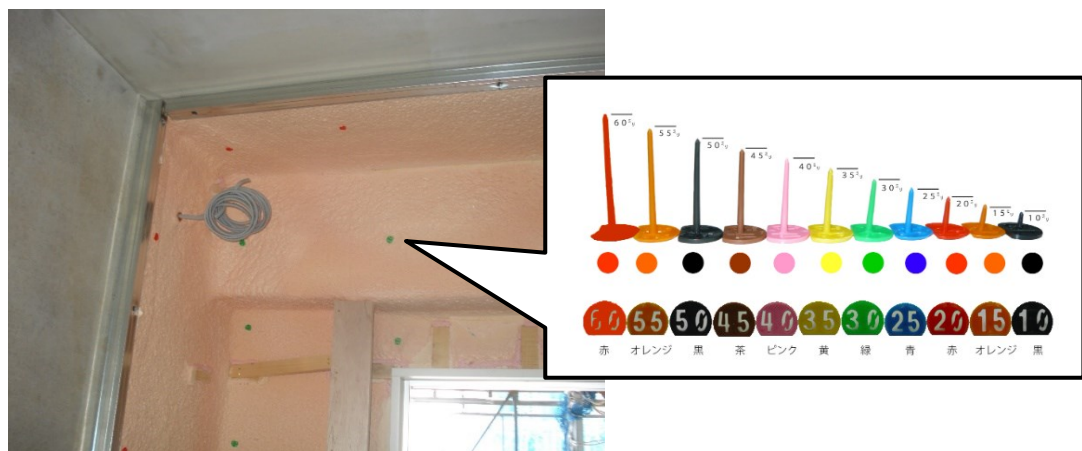
図 2-1-2 断熱材の施工写真の例（RC 共同住宅の外壁部分）
